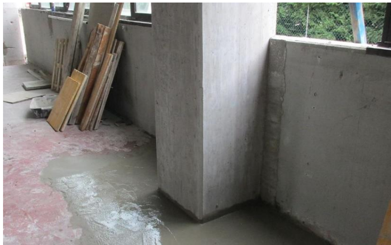
Ringrosso di pilastri e rifacimento base
