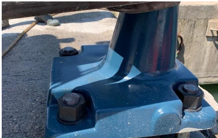
Inghisaggio di una bitta
