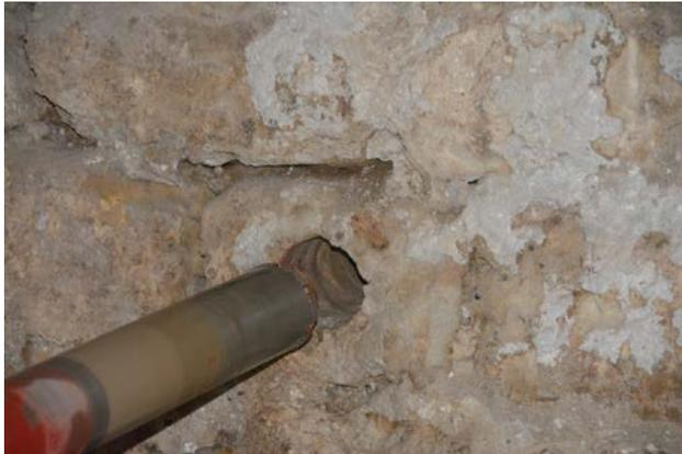
Nelle strutture in muratura il carotaggio è particolarmente indicato per conoscere la composizione materica e l'esatta stratigrafia dell'elemento.
