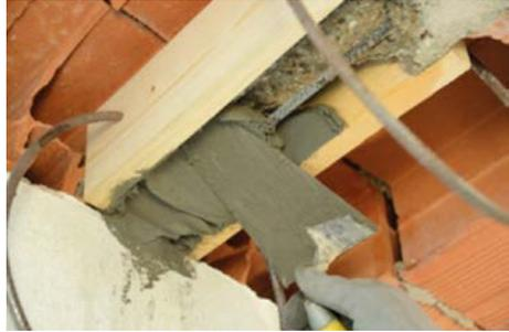
Preparazione delle superfici e ricostruzione dei travetti
